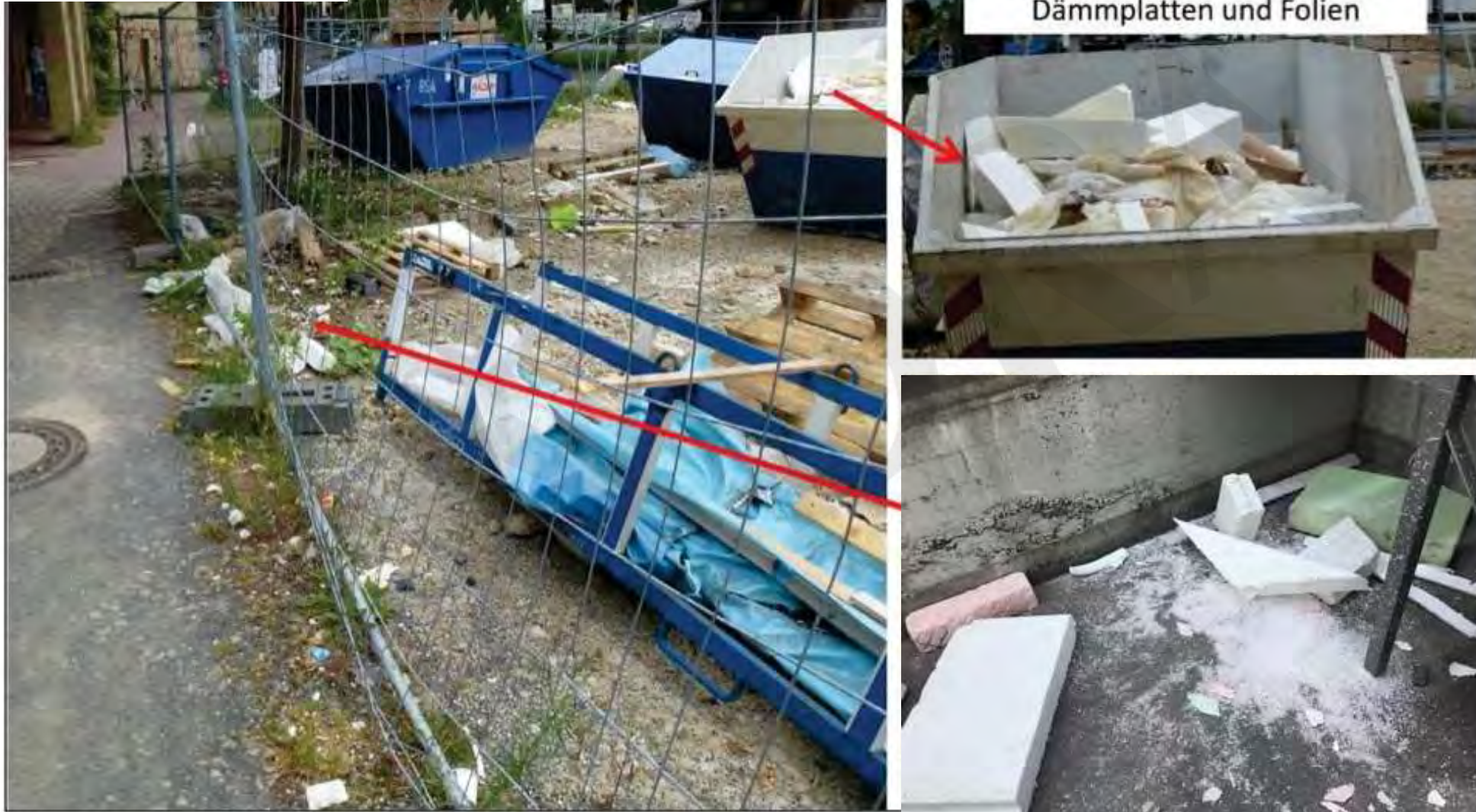
Ungesicherter Bauabfallcontainer mit EPS-Dämm-platten und Folien sowie daraus entstandene Verwehungen der Abfälle
